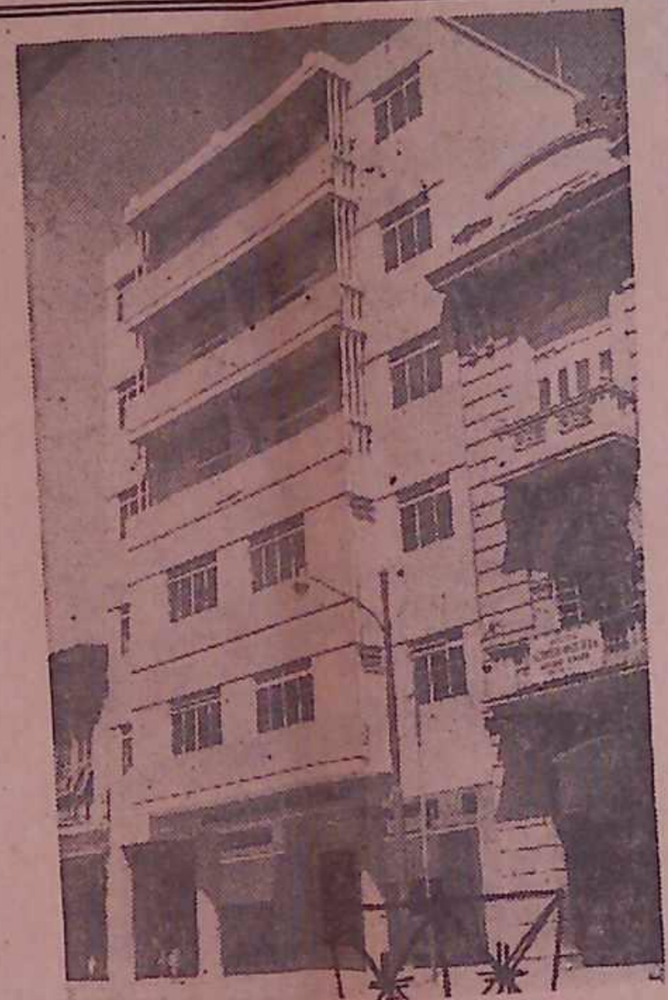
MODERNO EDIFICIO DE LA SOCIEDAD HIJOS DEL TRABAJO.
